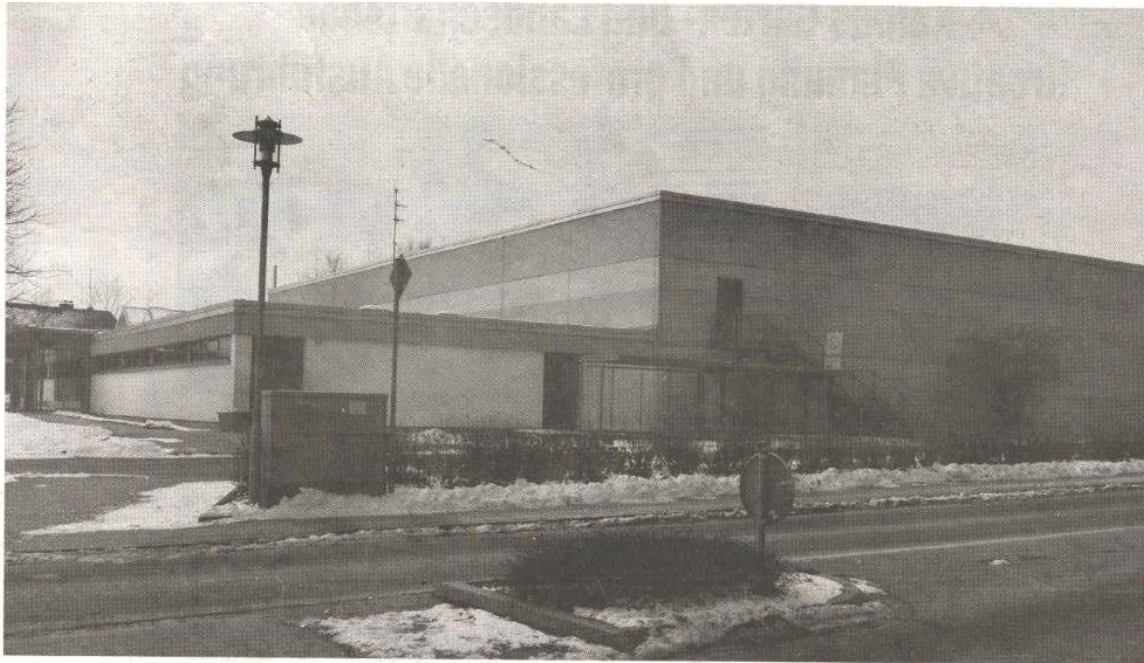
Die Vergaben für die energetische Sanierung der Sporthalle sind genehmigt.
