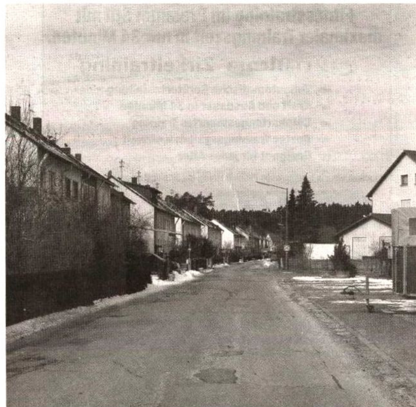
Wird in wenigen Wochen saniert: die Ezelsdorfer Pfaffenherdstraße. F.: Spandler
